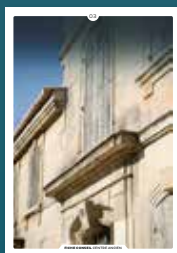
03 les façades en pierre de taille
