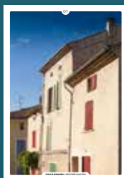
01 les façades enduites
