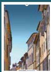
06 les débords de toiture
