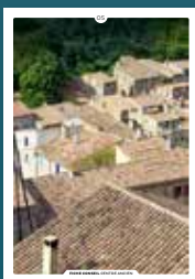
05 les toitures en tuiles rondes
