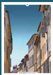
06 les débords de toitures
